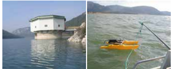
Şekil 1. Tahtalı Baraj Gölü su alma yapısı ve gölde yapılan akım hızı ölçüm çalışmaları [1]
