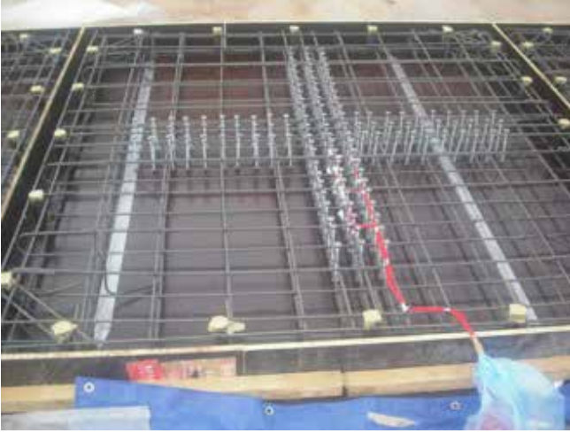
Şekil 3. Betonarme döşemelerde kayma donatısı
