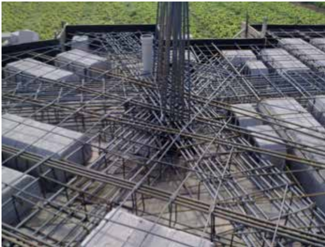
Şekil 4. Geniş-kirişli dolgulu dişli döşeme (asmolen döşeme) yapılar da kiriş-kolon bağlantı bölgesinin gerçek uygulamalarda ulaşabileceği karmaşıklığa bir örnek
