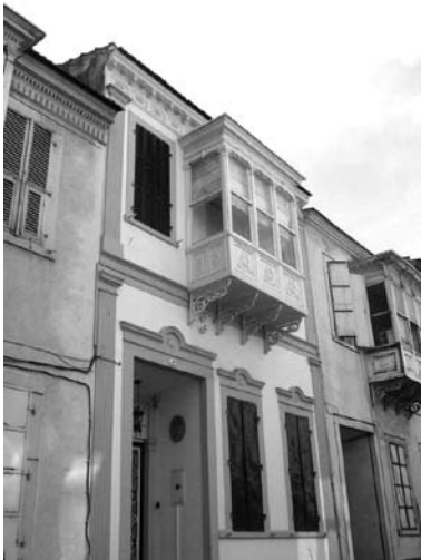
Resim 8a. Tipik bir 19. yüzyıl İzmir konutu. Cumba, asimetrik cephe kurgusu, yükseltilmiş bina girişi, söve ve diğer cephe süsleme elemanları ile kent genelinde karşılaştığımız bu konut türü cumhuriyetin kuruluşuna değin üretilmiştir. Kaynak: Şeniz Çıkış Arşivi.
