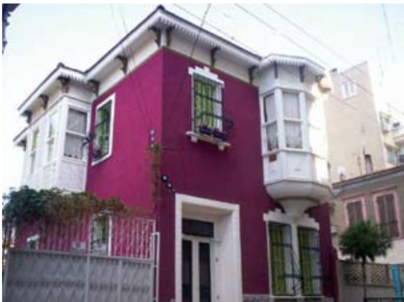
Resim 11a, 11b, 11c. İzmir Köprü'de konvansiyonel 19. yüzyıl İzmir konutunun etkilerini taşıyan bir eve ait görünüş ve planlar. Kaynak: Ş. Çıkış Arşivi.
