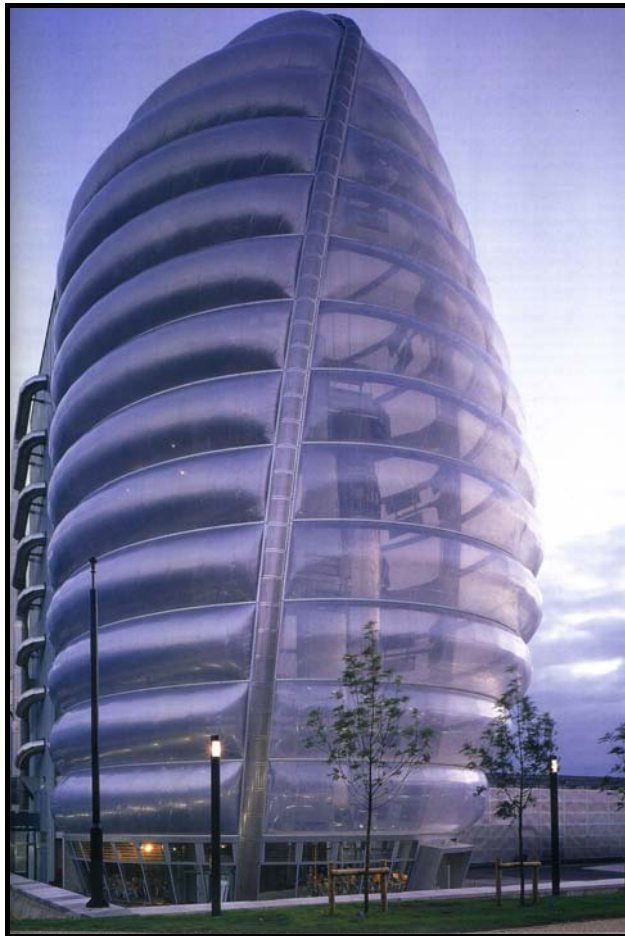
Fig. 3.31. NSSC Façade Cladding Source: a+u 385, 2002
