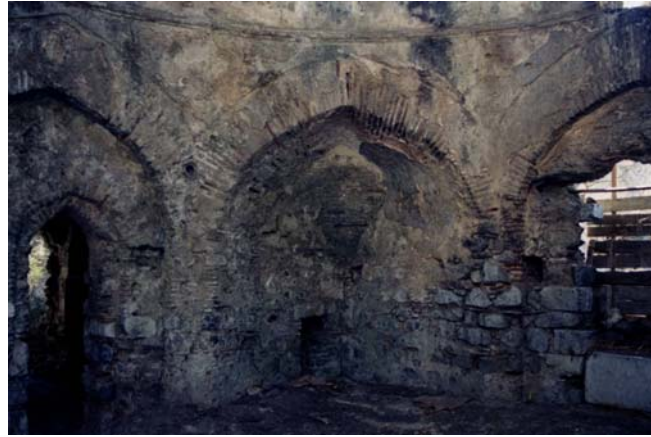
Figure 4.14. Düzce (Hereke) Hamamı, The Squinch of Soyunmalık Space
