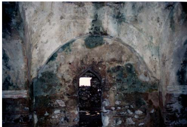
Figure 4.11. Düzce (Hereke) Hamamı, The Blind Niches in the Main Sıcaklık Space
