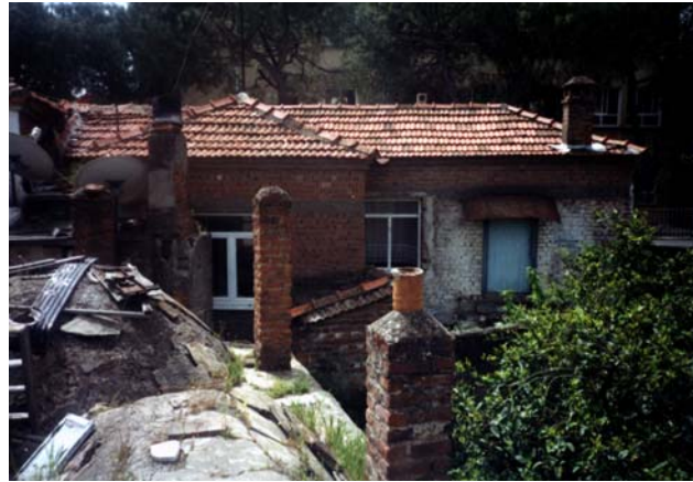
Figure 4.12. Seferihisar Büyük Hamam, The Flue Chimneys
