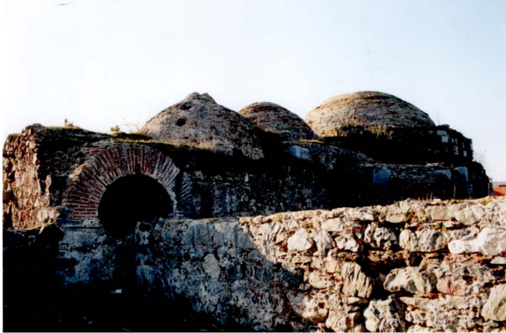
Figure 3.16. Düzce Hamamı, The Water Reservoir
