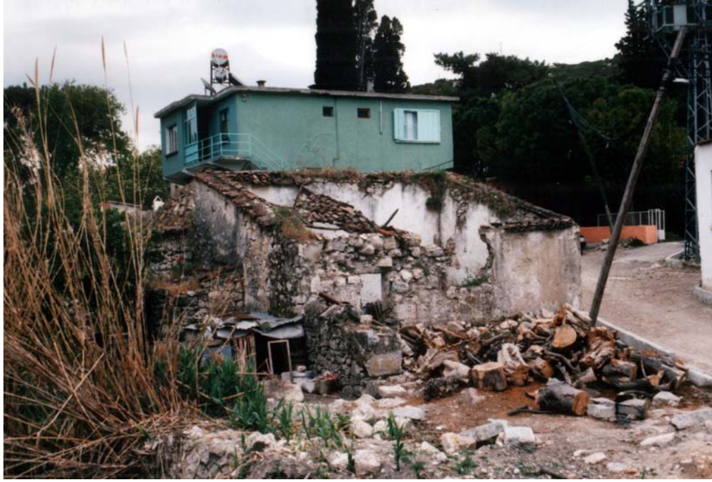
Figure 3.66. General View of the Urla Özbek Hamamı
