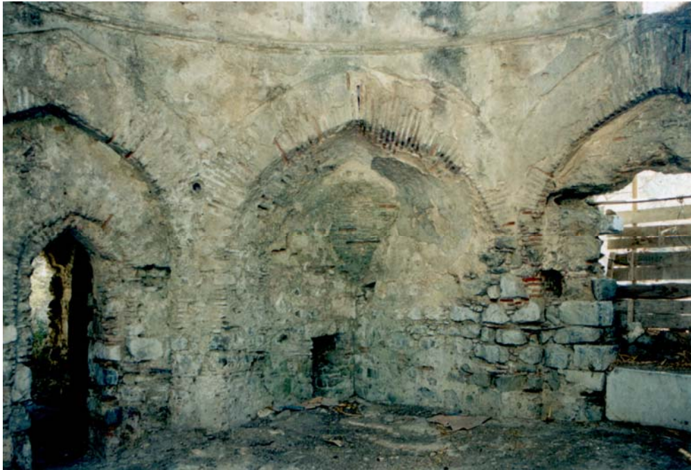
Figure 3.17. Düzce Hamamı, The Squinch in the Soyunmalık
