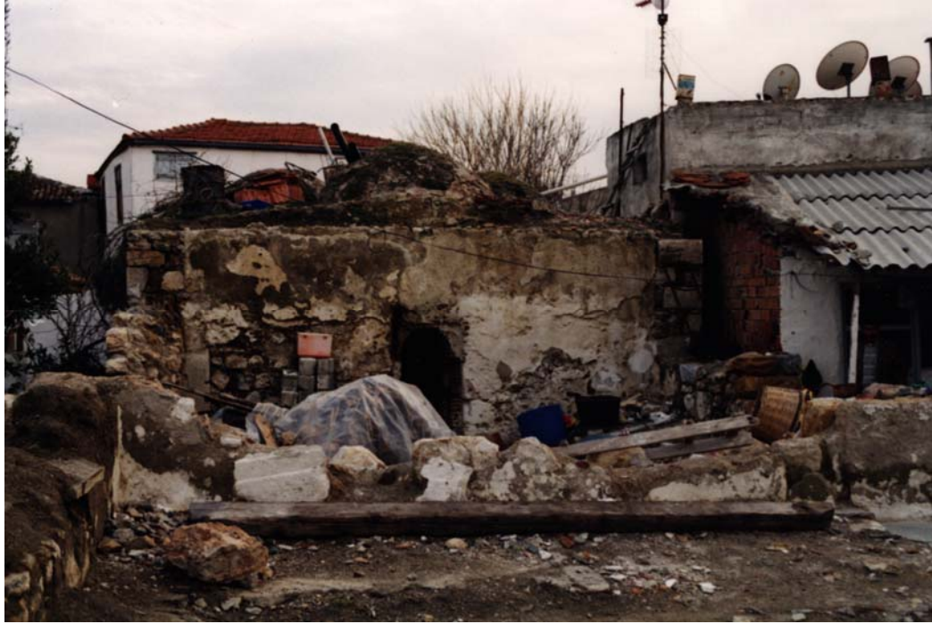
Figure 3.35. General View of the Sığacık Kaleiçi Hamamı
