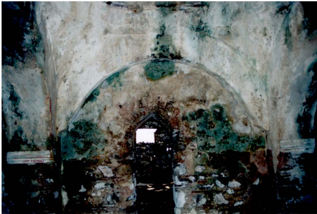
Figure 3.15. Düzce Hamamı, The Semi-circular Blind Niche in the Main Sıcaklık Space
