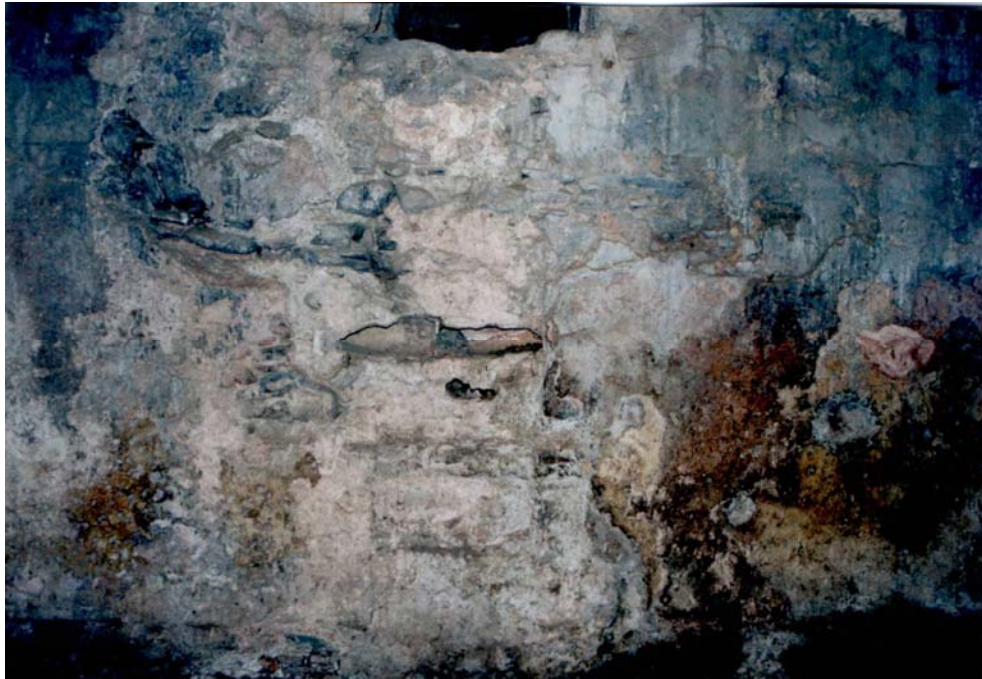
Figure 3.7. Ulamiş Hamamı, Terracotta Pipes in the West Halvet
