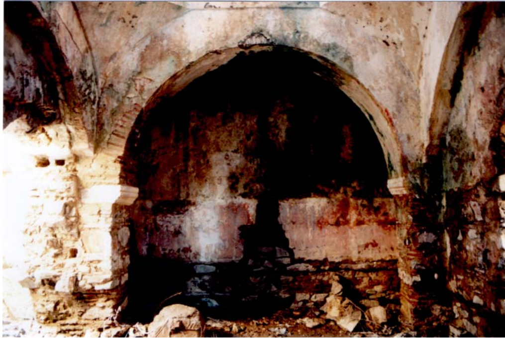
Figure 3.14. Düzce Hamamı, The Semi-circular Arch in the Main Sıcaklık Space
