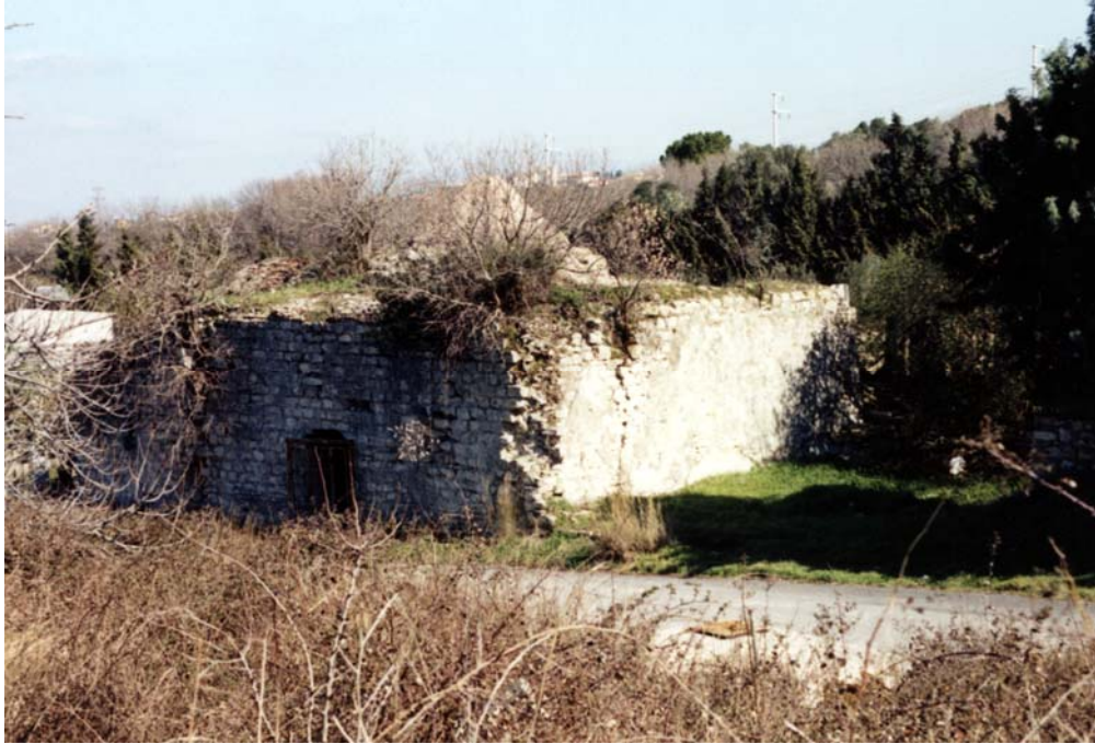
Figure 3.50. General View of the Urla Kamanlı (Yahşi Bey) Hamamı
