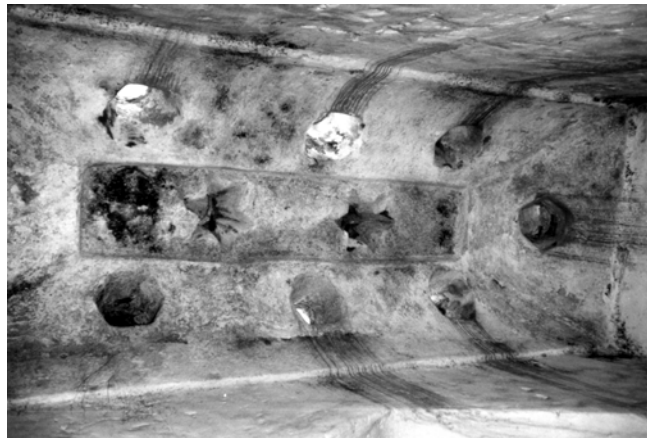
Figure 4.19. Seferihisar Büyük Hamam, Panelled Vault of the Sıcaklık Main Space
