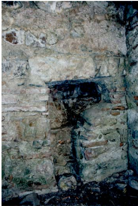
Figure 3.13. Düzce Hamamı, The Trace of Terracotta Pipes in the Soyunmalık
