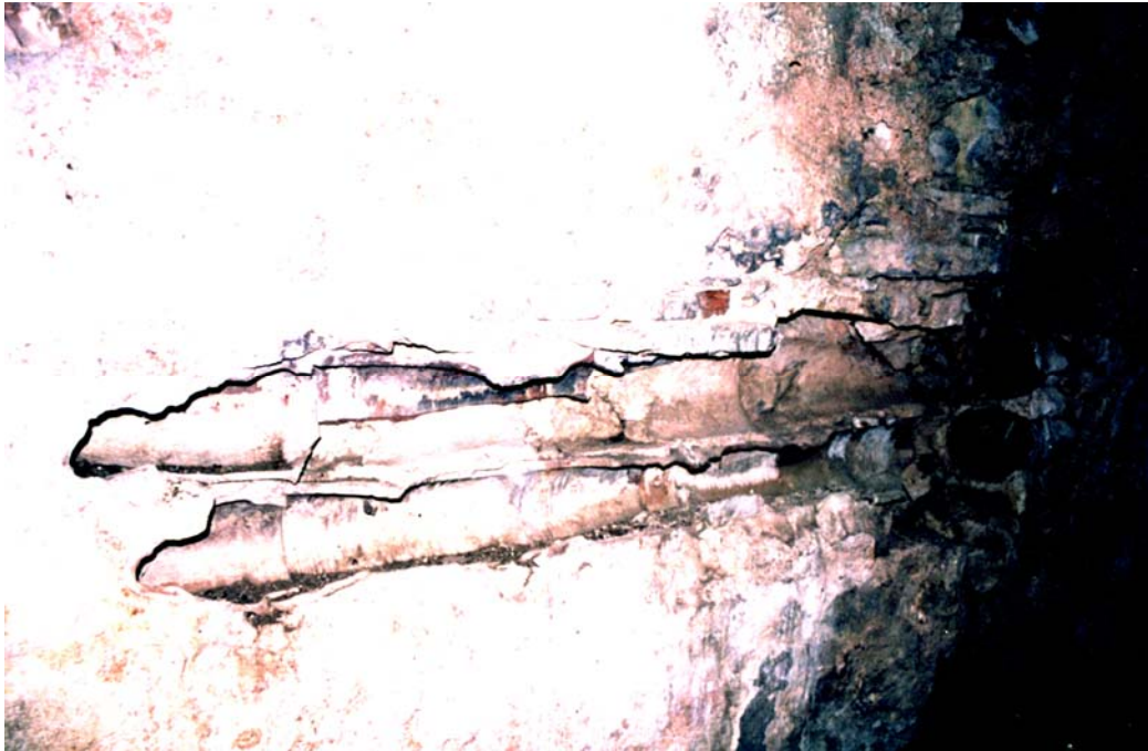
Figure 3.57. Urla Kamanlı Hamamı, Terracotta Pipes in the Main Sıcaklık Space
