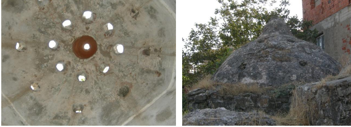
Figure A.72. Seferihisar Küçük Hamam, interior and exterior views of ilıklık / sıcaklık main space dome.
