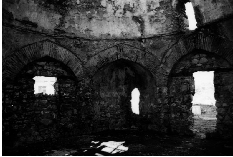
Figure 3.56. In Düzce Hamamı soyunmalık dome, the use of windows at the springing level.
