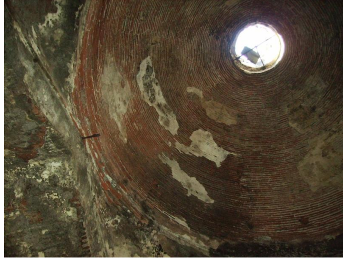
Figure 2.9. Tire Yalınayak Hamamı men's section soyunmalık domes in semi-circular profile.
