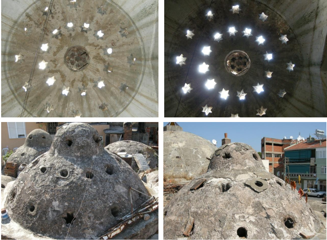
Figure A.67. Seferihisar Büyük Hamam, interior and exterior views of sıcaklık main space dome.
