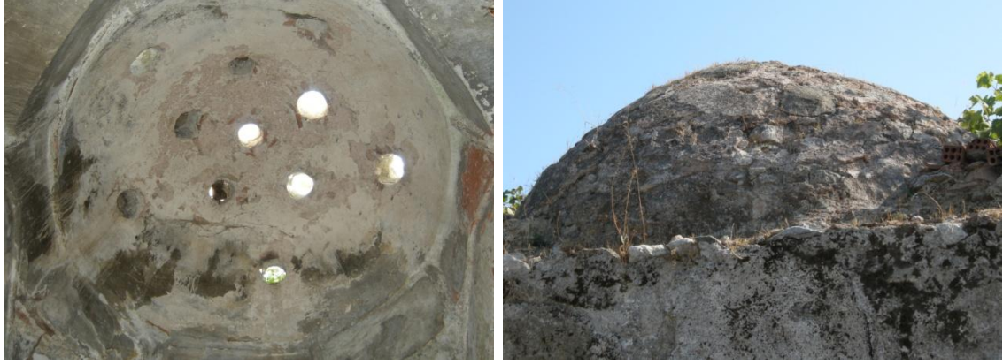
Figure A.77. Sığacık Kaleiçi Hamam, interior and exterior views of ılıklık / sıcaklık main space dome.
