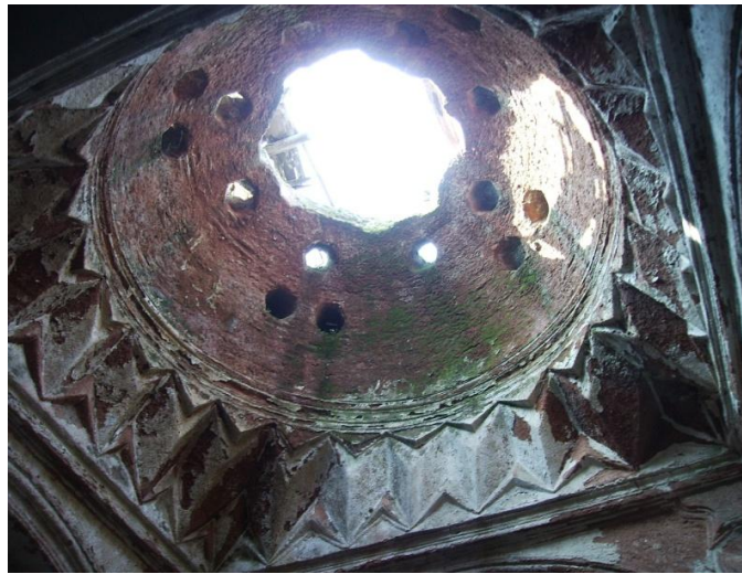
Figure 2.8. Tire Tahtakale Hamamı men's section sıcaklık main space dome in semi-circular profile.
