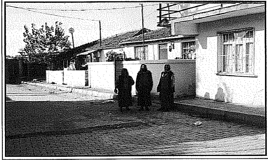
Fotoğraf 4.4.3 Asarlık'ta onarım görmüş olan gecekondular
