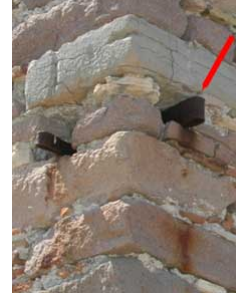
Şekil 58. Duvar köşelerindeki kenetler.
