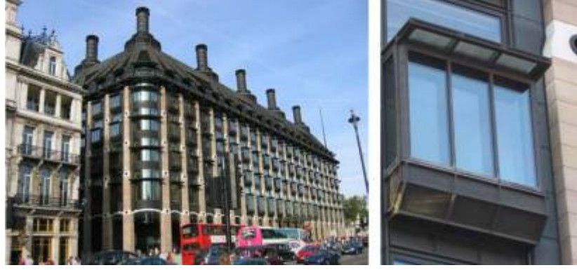
Şekil 44. Şaft kutu cephe örneği (Tascon, 2008)
