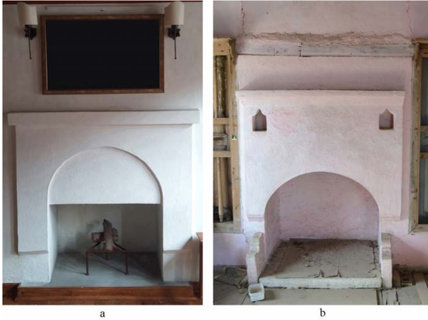
Şekil 2. Geleneksel ocaklar a: Gürsel Evi 1K2 odasındaki ocak, b: Sönmezer Evi 1K3 odasındaki ocak (Traditional fireplaces/ocaks a: ocak in 1K2 room – Gürsel House, b: ocak in 1K3 room – Sönmezer House)
