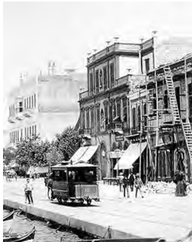
Resim 6. Yapım çalışmaları sırasında Kramer Palas Oteli.
