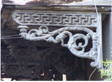
Resim 12a. Döküm demir konsol. Bu dönemde yapılan demir konsolların neredeyse tümü birbirinin aynıdır.
