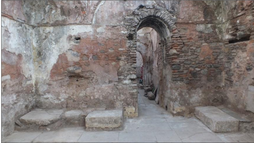
Figure 2.13. Eski Hamam G04 Sıcaklık
