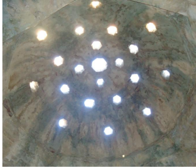
Figure 4.119. Dome plaster of Sıcaklık
