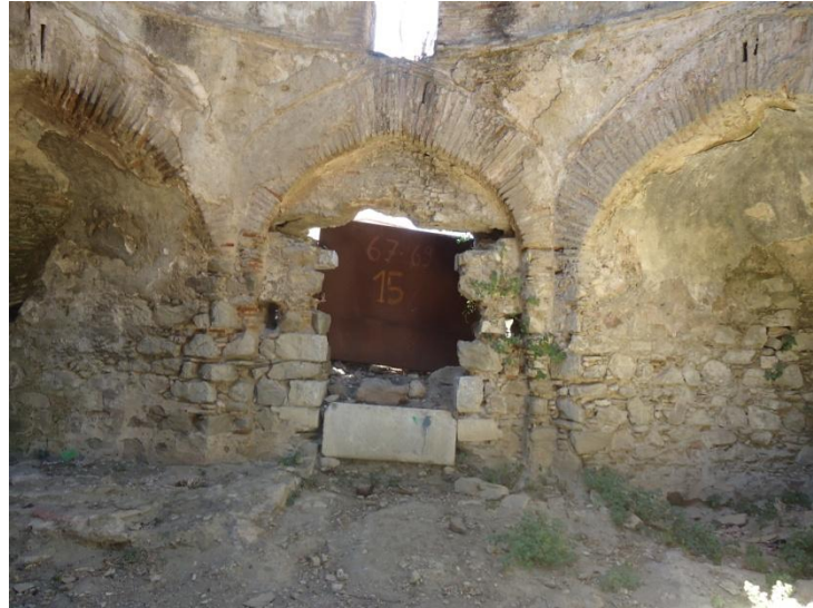
Figure 3.16. Walls of Soyunmalık
