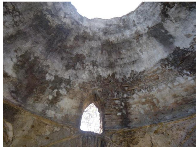
Figure 3.20.Düzce Bath Soyunmalık dome top window
