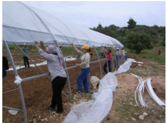
Karaburun'da İşsizliğin Azaltılması Projesi kapsamında örnek seralar inşa ediliyor
