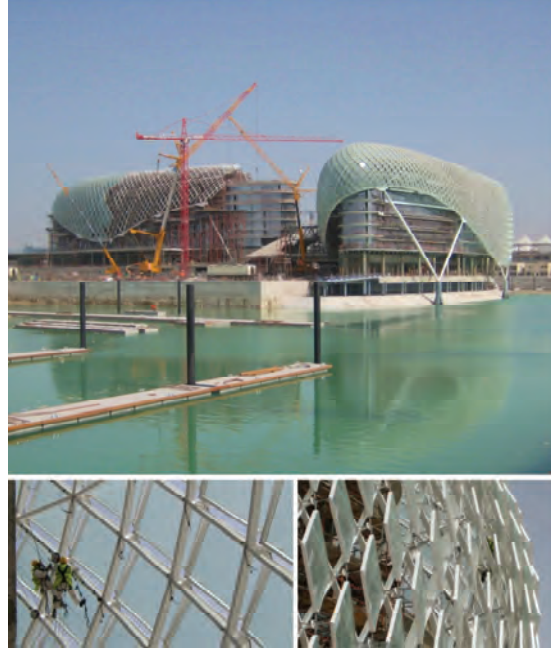
Şekil 21: YAS Oteli inşasından fotoğraflar. Dörtgen bölümlendirme ile burulmasız düğüm noktaları elde edilmiştir. (Waagner-Biro Stahlbau)
