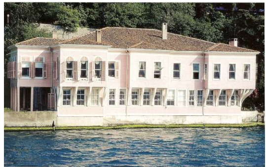
Figure 3.74. Window series on the facade of Fethi Paşa Yalısı. (Source: Günay 1997)
