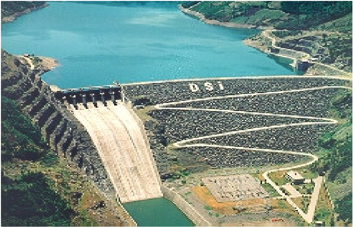
Figure 2.7. Hasan Uğurlu Dam.
