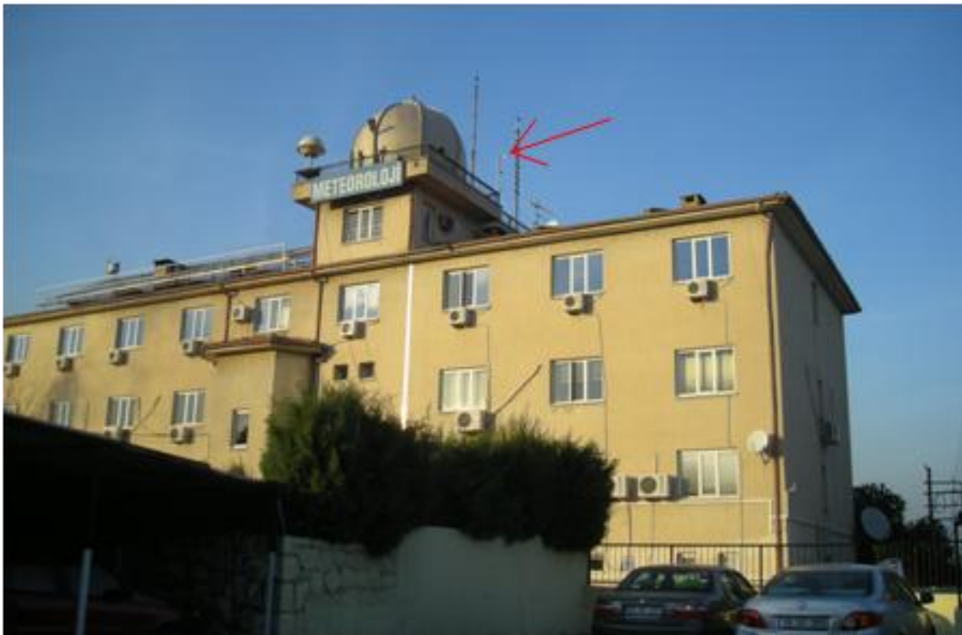
Figure 1.12. The Meteorology Office building in Güzelyalı.
