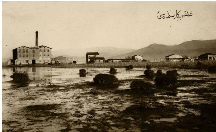
Figure 35. Tuzakođlu Flour Plant (Source: https://adv.sozcu.com.tr/kesfet/mahall-bomonti-izmir/izmirdeki-obolgenin-kaderi-degisiyor/ )
