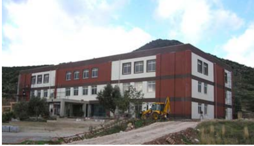
Mimarlık Fakültesi B Blok'un Güçlendirme Çalışmasından Sonraki Durumu - Kasım 2006
