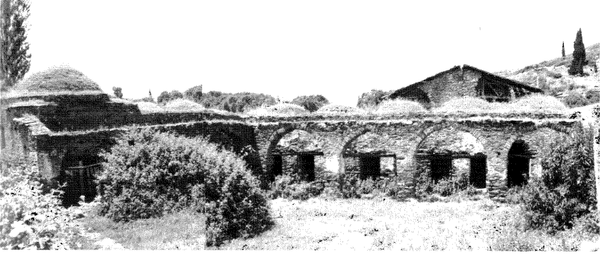
Şekil 2. Avludan genel görünüş
