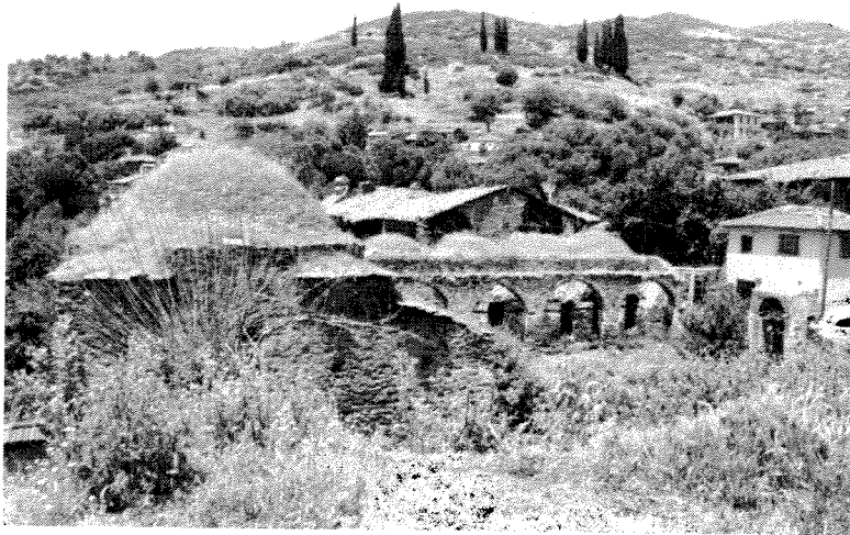
Şekil 1. Yapının genel görünüşü
