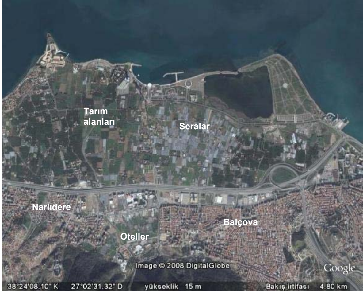
Şekil 3.15. Balçova Jeotermal Sahası, genel görünüm.
