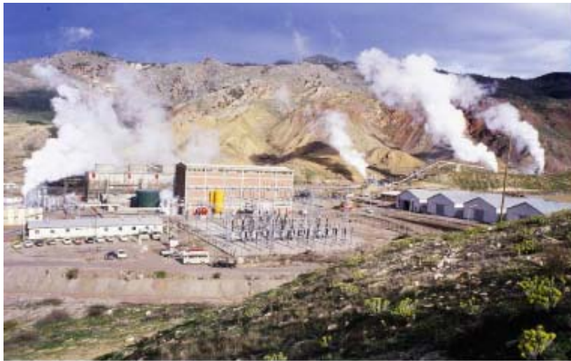
Şekil 3.4. Kızıldere Jeotermal Santrali, genel görünüm.
