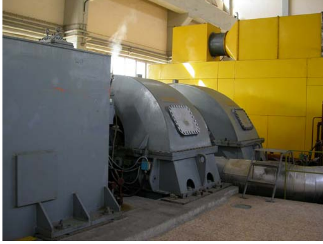
Şekil 3.11. Türbin-jeneratör ünitesi.
