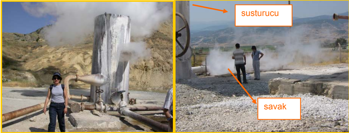
Şekil 3.9. Susturucu ve savağı.
