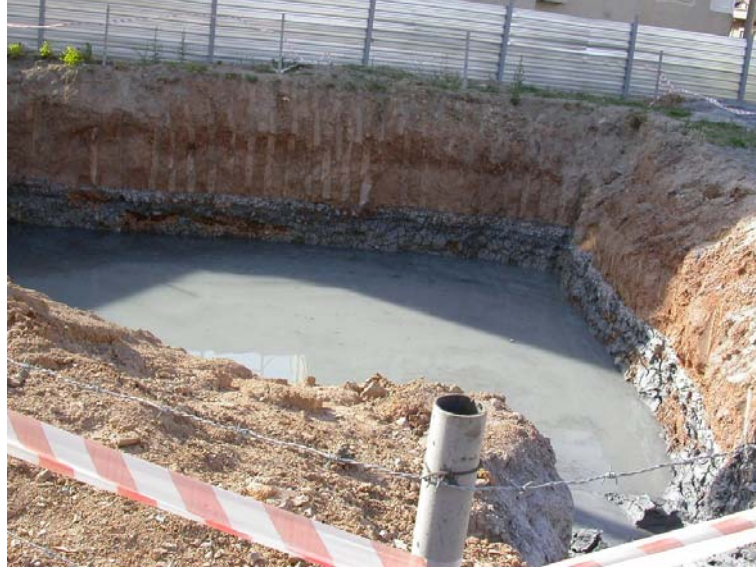
Şekil 4.5. BD11 kuyusu sondajı, çamur havuzu.
