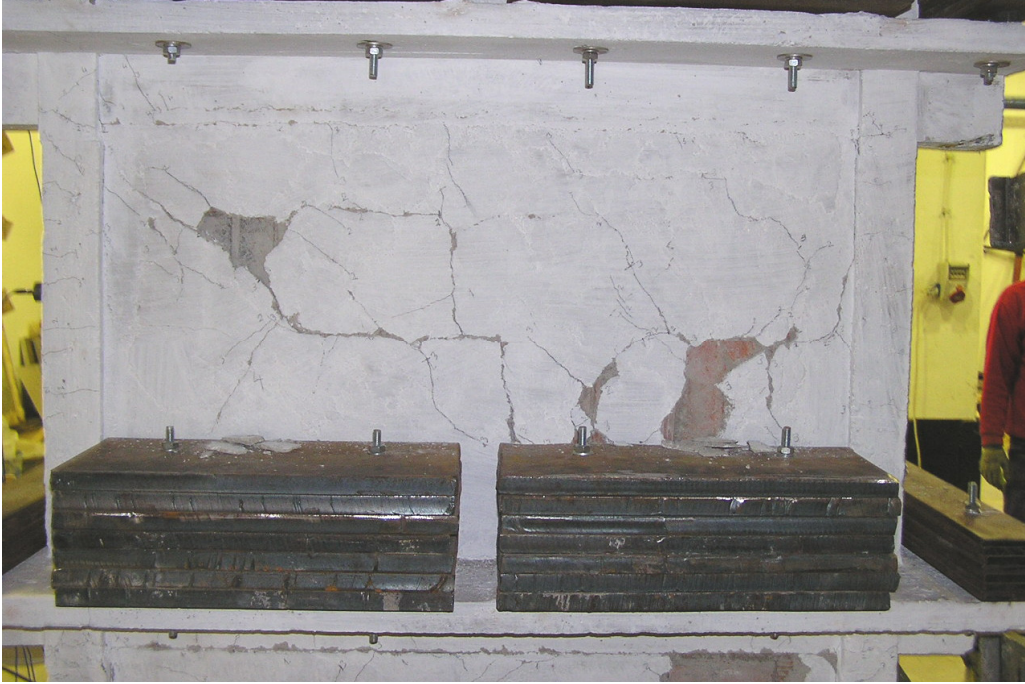
Şekil 4.45 Grup 6 yüklemeleri sonrası 2. kat güney yüzünde oluşan hasarlar
