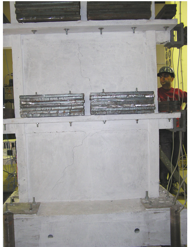
b) Dolgu duvarlarda oluşan çatlaklar
