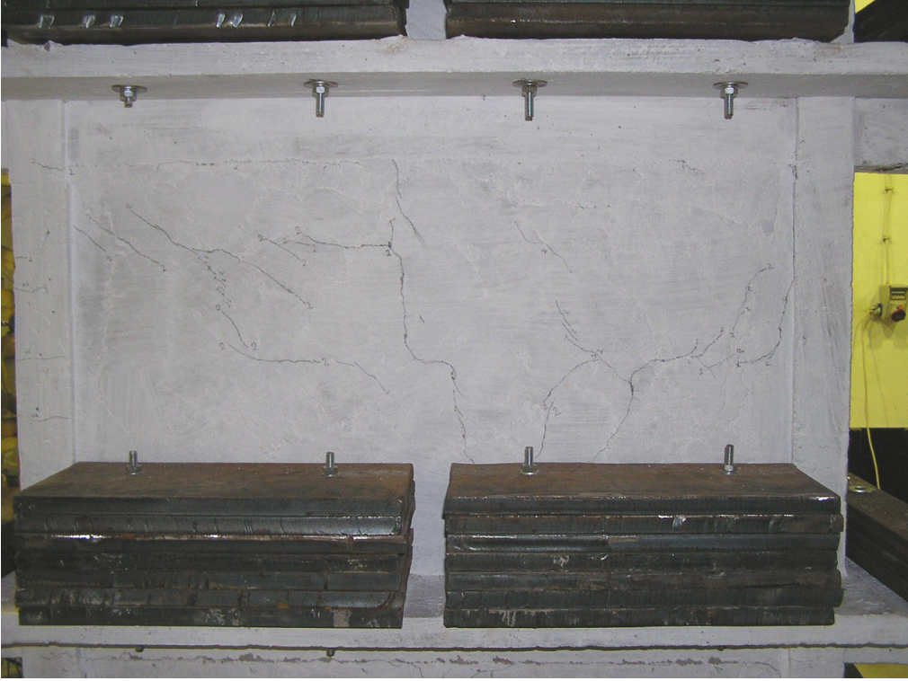
Şekil 4.36 Grup 2 yüklemeleri sonrası 2. kat güney yüzünde oluşan hasarlar
