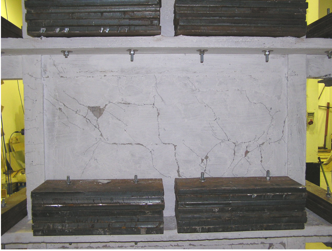
Şekil 4.41 Grup 4 yüklemeleri sonrası 2. kat güney yüzünde oluşan hasarlar
