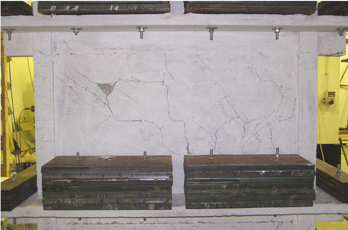
Şekil 4.39 Grup 3 yüklemeleri sonrası 2. kat güney yüzünde oluşan hasarlar
