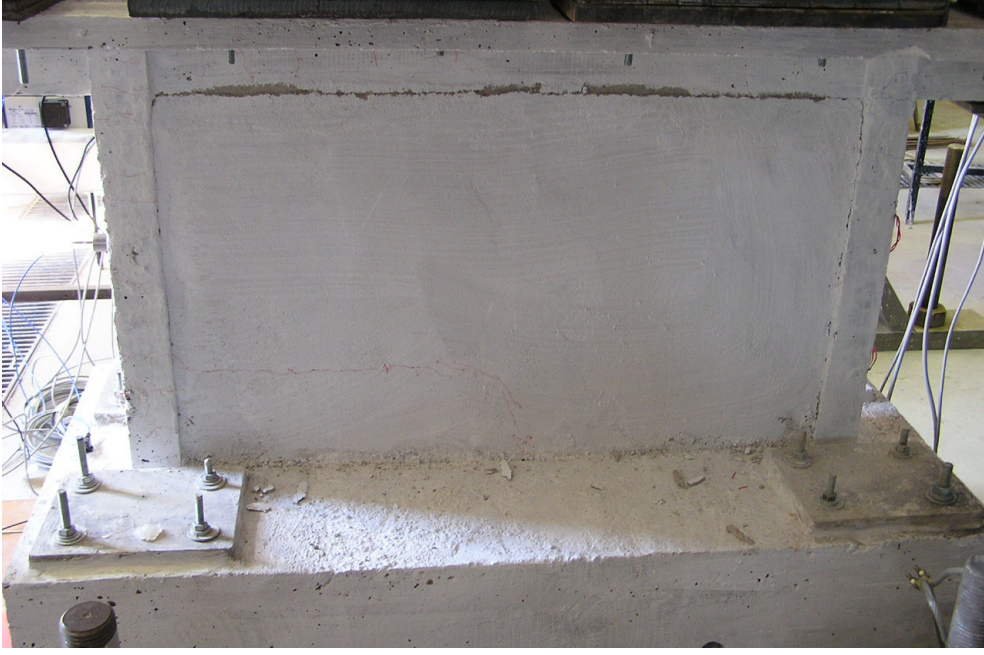
Şekil 4.50 Grup 3 yüklemeleri sonrası 1. kat güney yüzünde oluşan hasarlar
