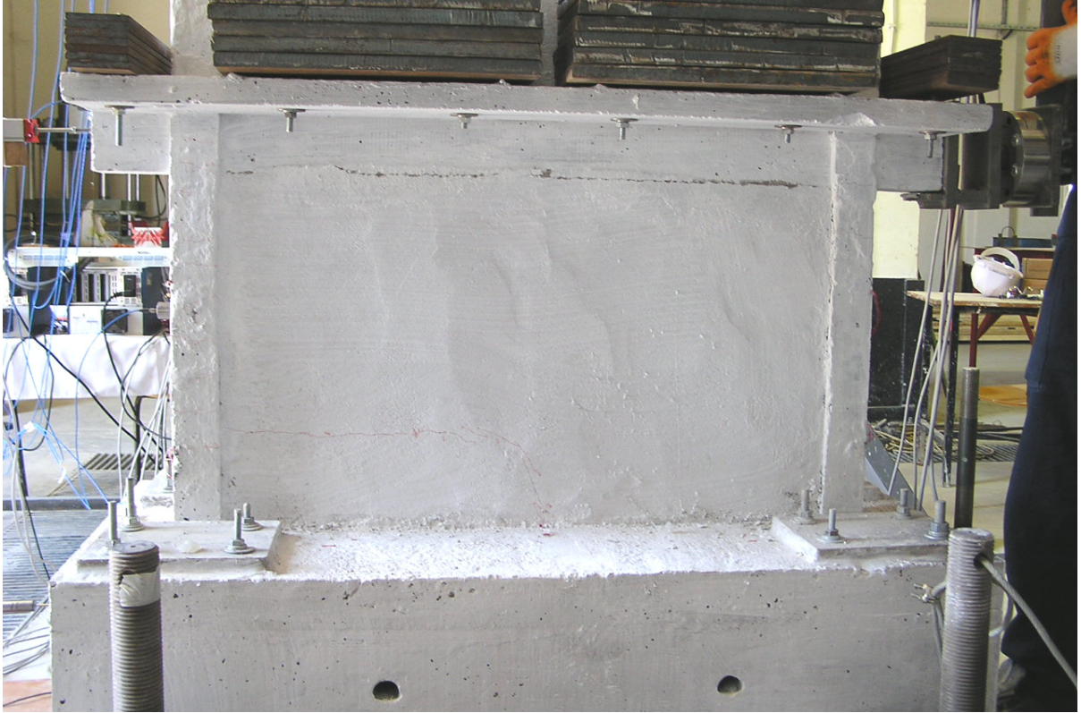
Şekil 4.48 Grup 2 yüklemeleri sonrası 1. kat güney yüzünde oluşan hasarlar
