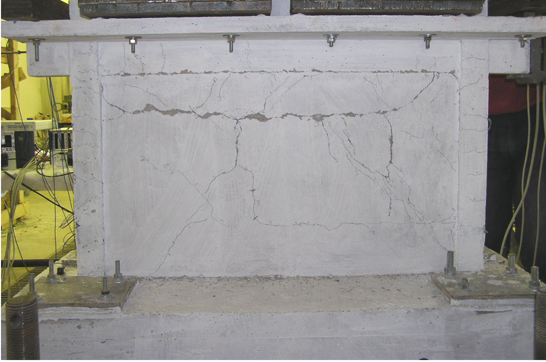
Şekil 4.38 Grup 3 yüklemeleri sonrası 1. kat güney yüzünde oluşan hasarlar
