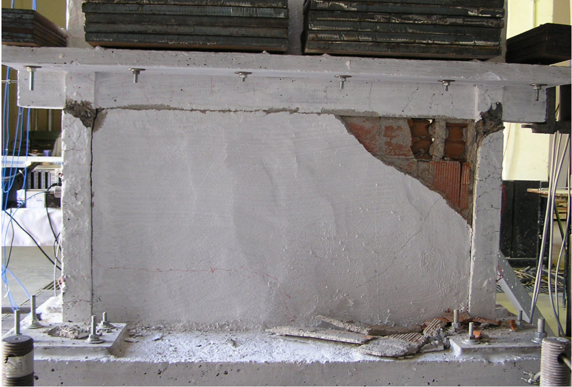
Şekil 4.53 Grup 6 yüklemeleri sonrası 1. kat güney yüzünde oluşan hasarlar ve deney sonu
