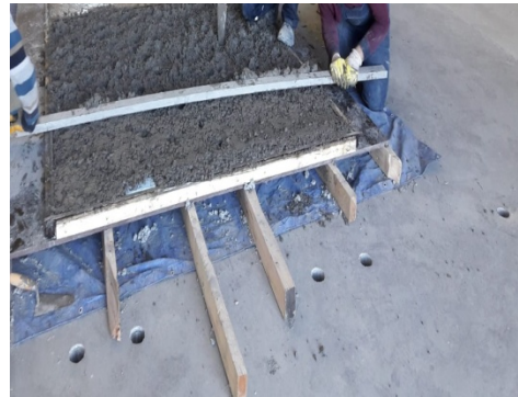
(d) Pouring & distributing into formwork
