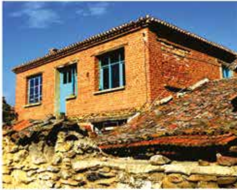
Foto. 37: Batı cephesi Photo. 37: West elevation
