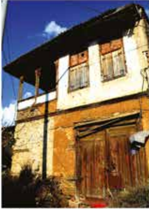
Foto. 22: Batı cephesi Photo. 22: West elevation
