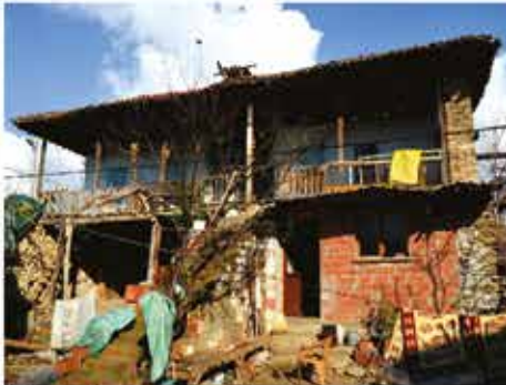
Foto. 30: Güney cephesi Photo. 30: South elevation
